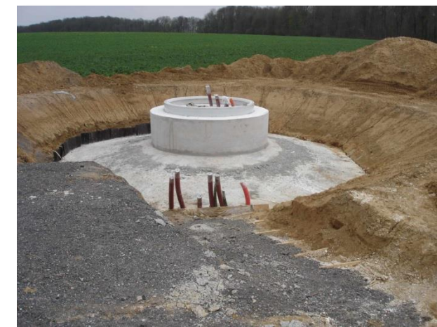
Béton terminé (Photo : VALOREM)
