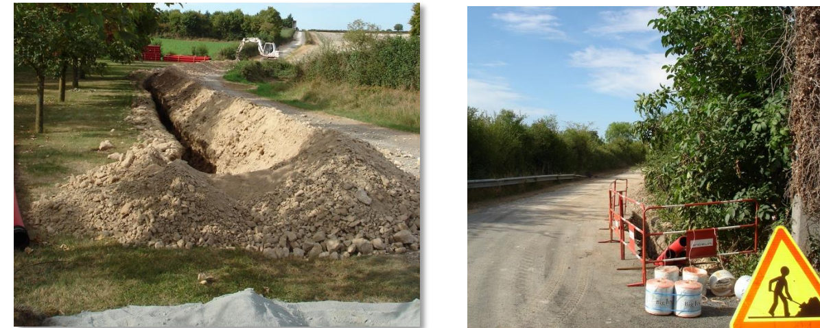
Figure 30 : Tranchée pour le raccordement au réseau local (Source : VALOREM)
