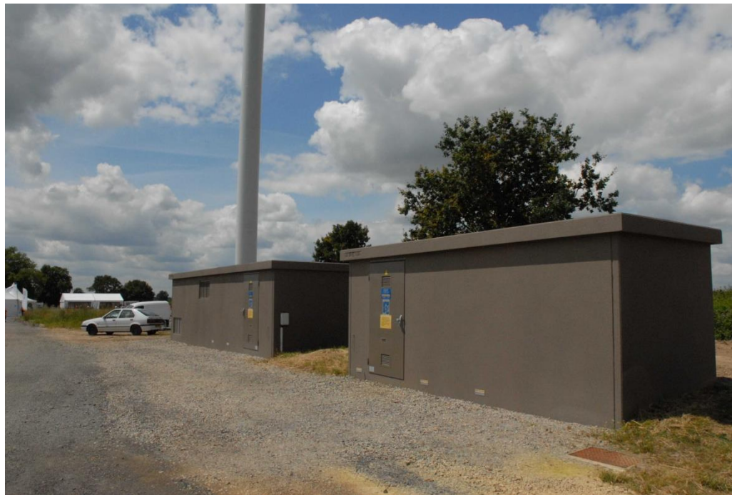
Figure 32 : Exemple de poste de livraison
