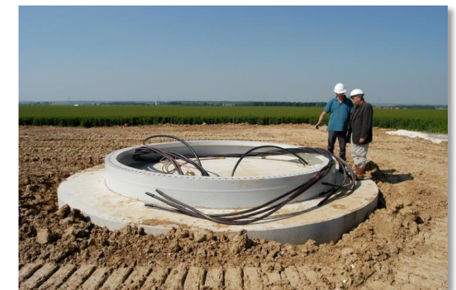
Fondation terminée (Photo : VALOREM)
